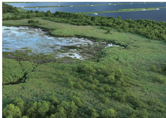
道央地域で湿地のすぐ隣にメガソーラーが建設されている場所
