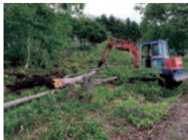
土木作業中の状況
